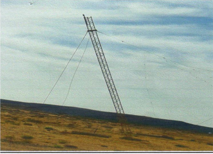
صور أبراج حديدية قائمة ومنهارة حاملة للشبكات بارتفاعات مختلفة (٣٠ متر ، ٢٠ متر) تقريبا :
