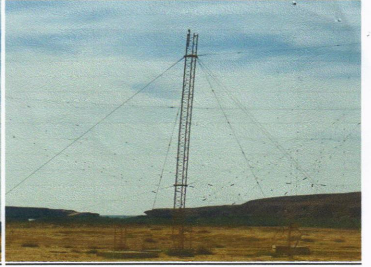
صور أبراج حديدية قائمة ومنهارة حاملة للشبكات بارتفاعات مختلفة (٣٠ متر ، ٢٠ متر) تقريبا :
