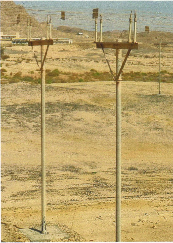
صور لخطوط النقل (سلك حديدي مجدول بطول ٣٩٣ متر) مثبتة على اعمدة حديدية مجلفنة بارتفاع ٤ متر تقريبا :
